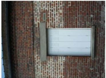
Le linteau cintré (ci-dessus) qui caractérise les ouvertures est supprimé notamment pour adapter les fenêtres aux dimensions standardisées. L'utilisation du ciment a entraîné d'une part un mauvais rejointement des briques (exemple ci-dessus) et d'autre part la disparition des encadrements et des bandeaux (exemple ci-dessous)
