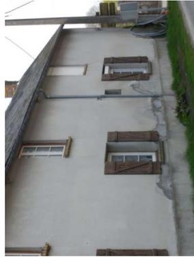
D'autre part, le traitement par l'enduit provoque des remontées d'humidité ascensionnelles sur les murs du bâti.
