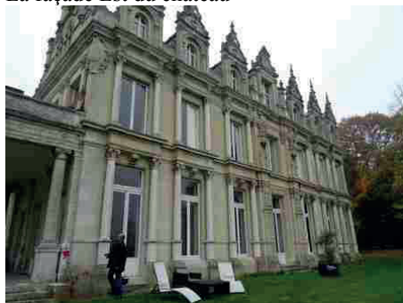
La façade sud vers la Seine
