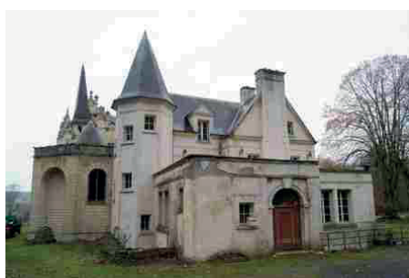
La façade Est du château
