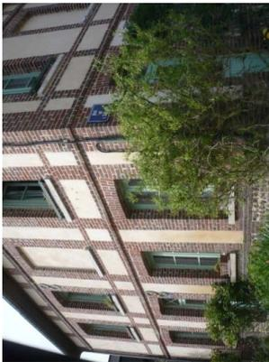
**La mise en valeur du bâti et de ses matériaux a été intégrée dans cette réhabilitation :** rejointement des briques pleines, conservation de soubassements en moellon et silex, toiture en ardoise naturelle, préservation des ouvertures, des volets battants et des encadrements en brique donnant le rythme à la façade.
