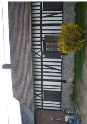
Le traitement par des joints en ciment des soubassements autour des silex est à éviter.
