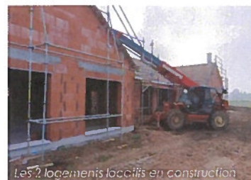
Les 2 logements locatifs en construction
