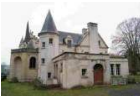
La façade Est du château
